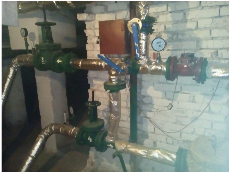
Рисунок 1.1 – Ввід теплової мережі
