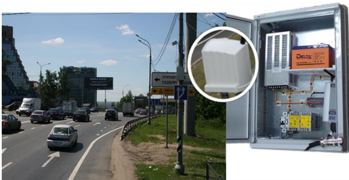
Рис. 2.4. Склад комплексу з детектором радіолокаційного типу [21]
