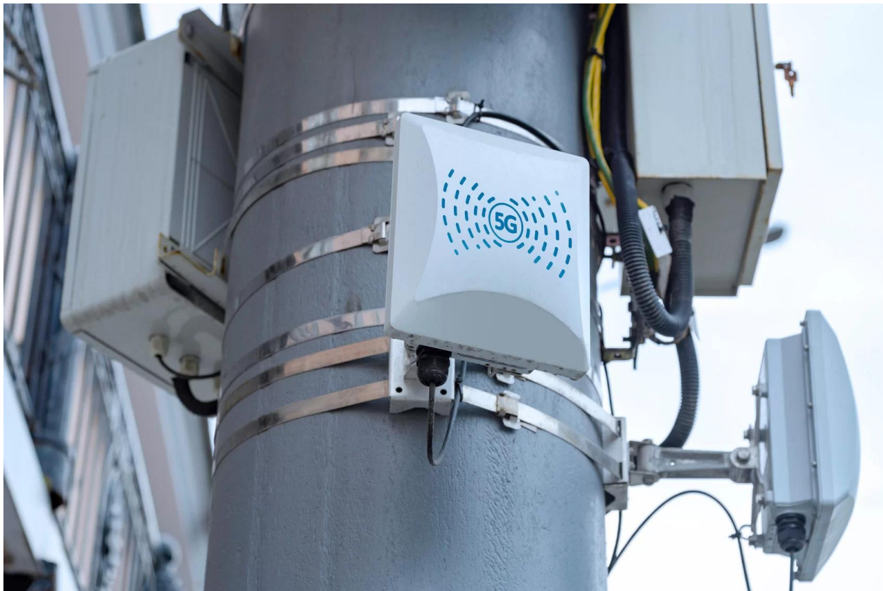
Рисунок 1.1 - Ретранслятори стільникового зв'язку 5G на стовпі
