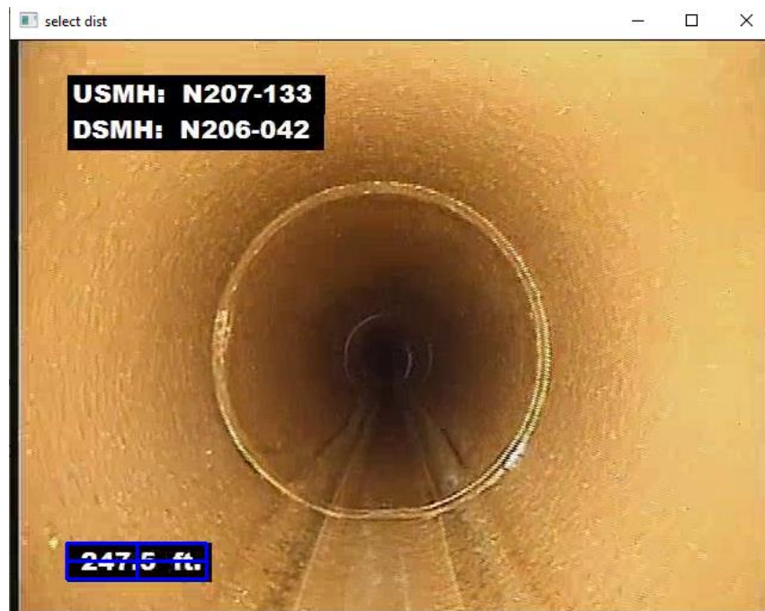
Рисунок 3.10 – Позначення координат одометра на випадковому кадрі відеоінспекції
