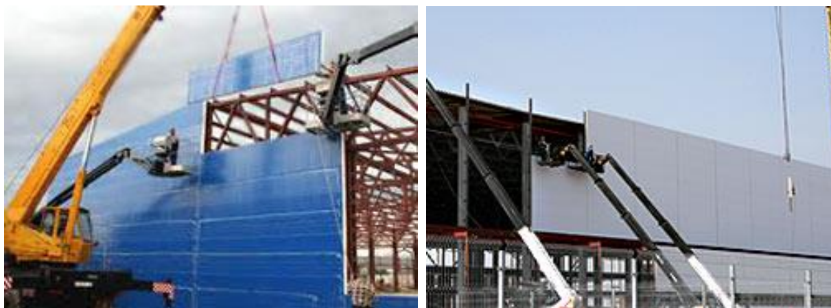
Рисунок 1.6 – Монтаж окремостоячого холодильника із сендвіч-панелей
