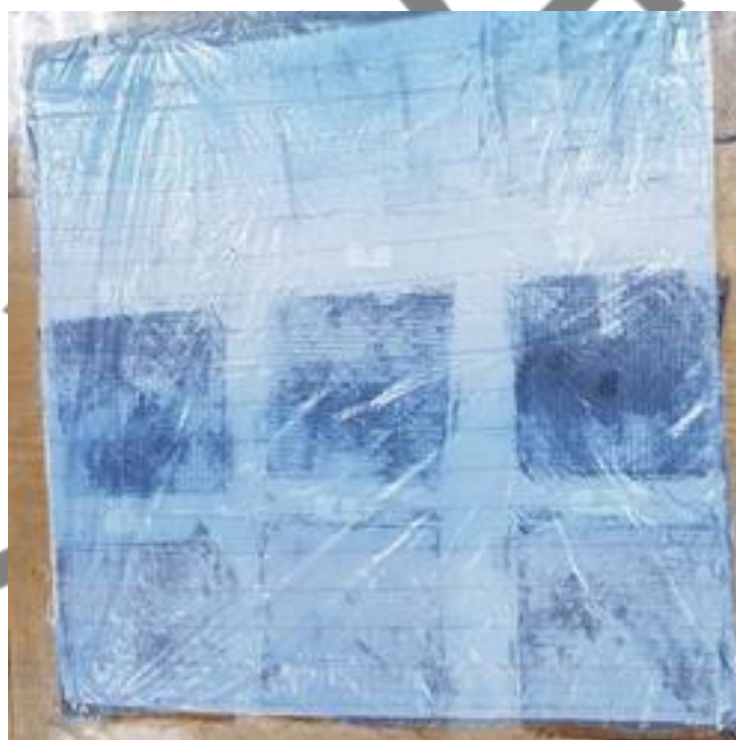
Рисунок 3.4 – Укладання перфорованої поліетиленової плівки.
