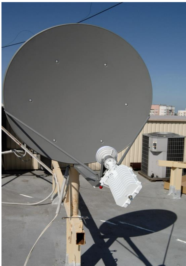
Рисунок. 2.6 - ВУС: блоковий перетворювач з підвищенням частоти
