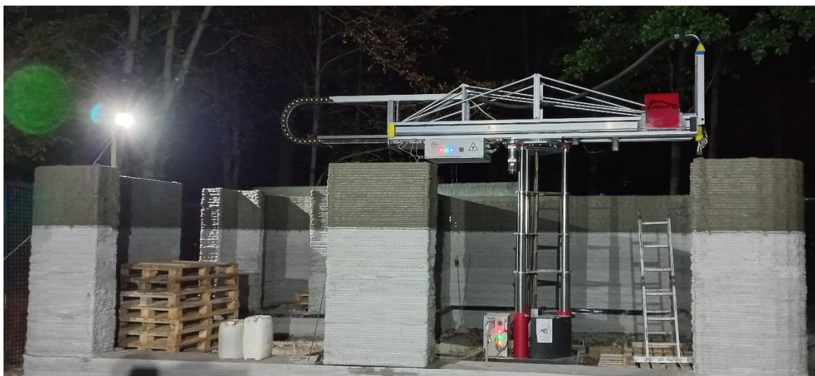
Рисунок 4.24 – Процес друку будівлі
