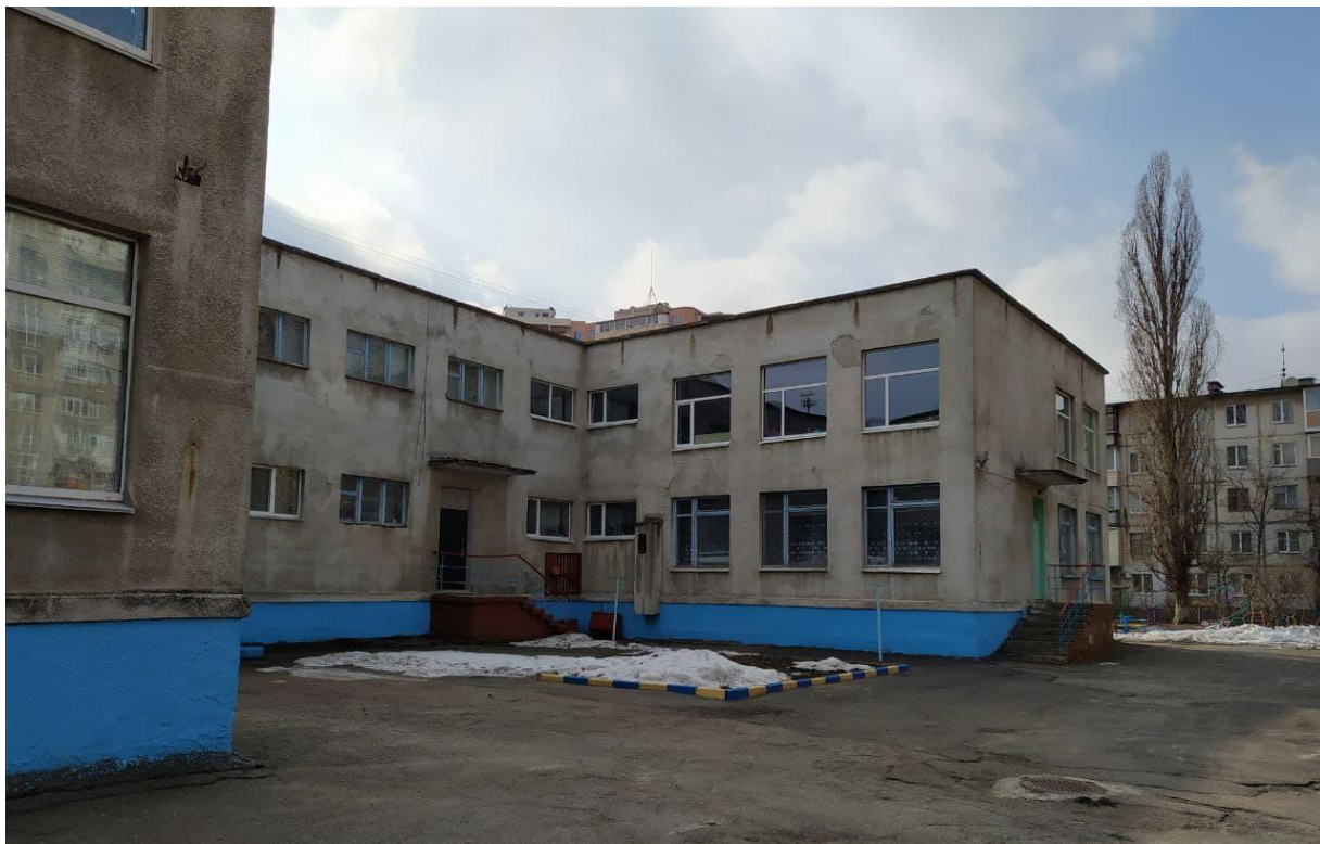
Рисунок 1.2 – Вигляд зовнішніх огорожувальних конструкцій закладу
