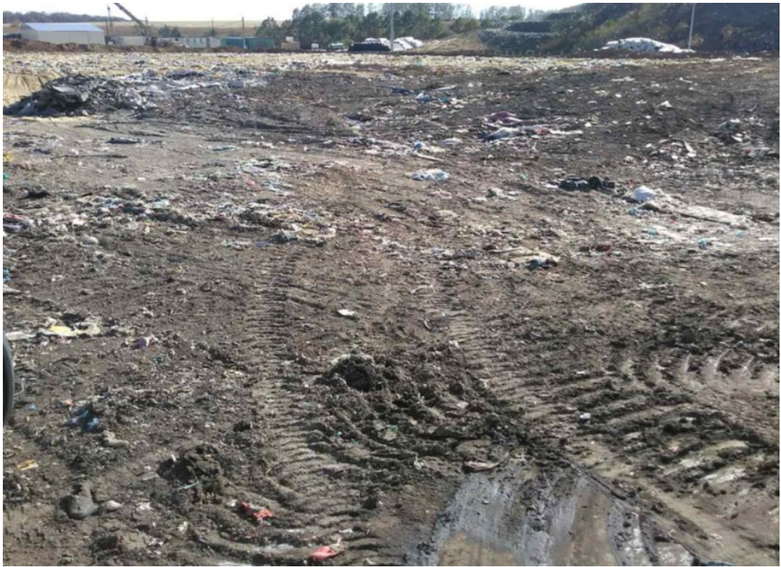
Рисунок 3.7 - Використання сухого залишку для підсипки полігону ТПВ
