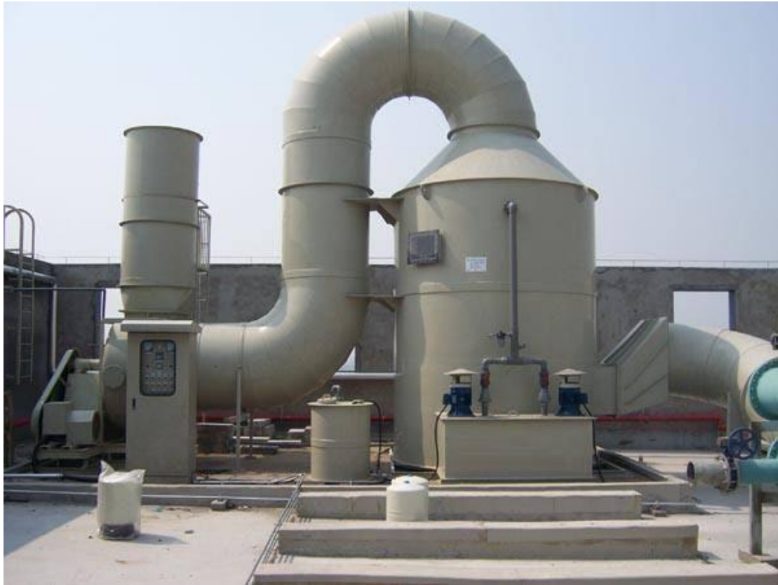
Рисунок 1.1 - Зовнішній вигляд абсорбційної колони
