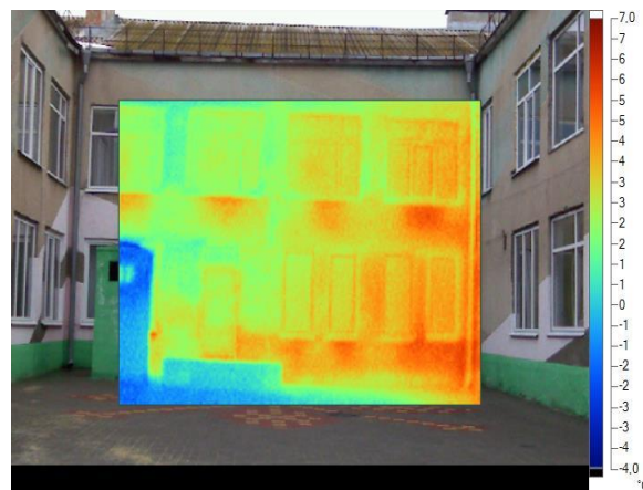
Рисунок В.1 – Термограми стану стін та кутових з'єднань
