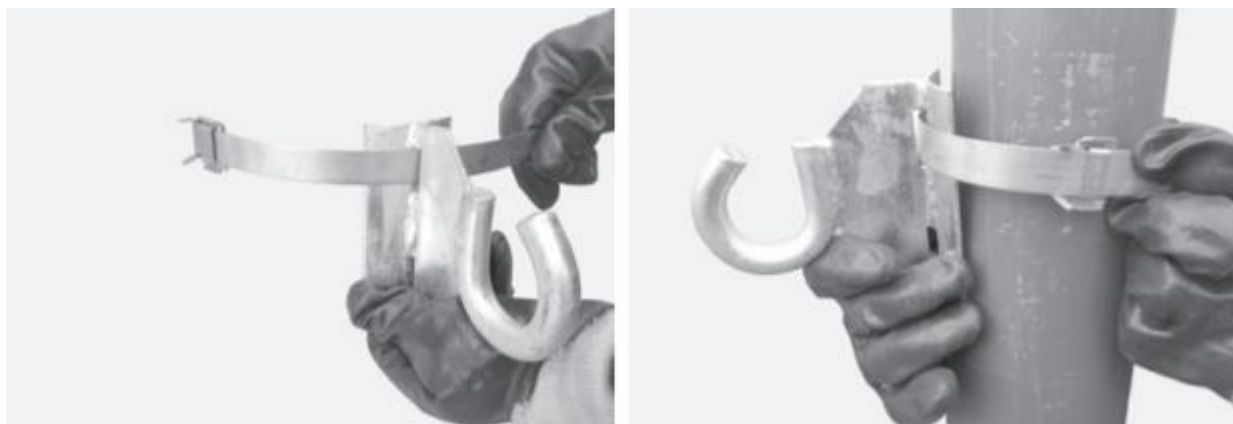
Рисунок 3.17 – Монтаж гаку
