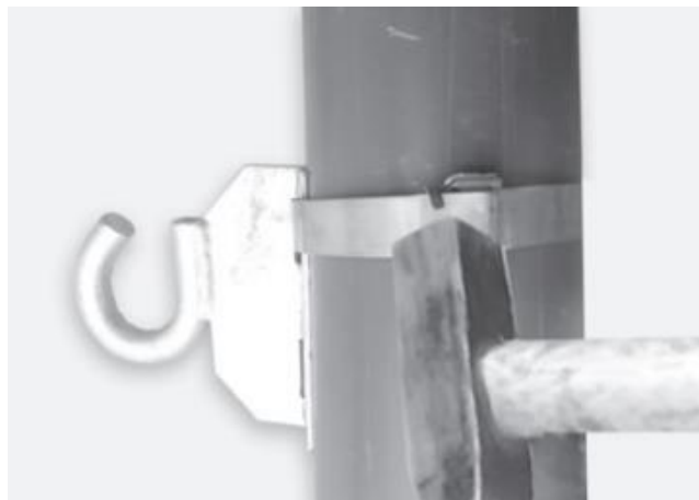
Рисунок 3.20 – Монтаж гаку
