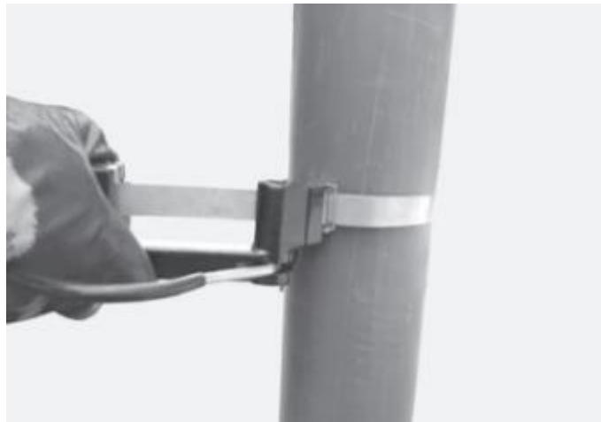
Рисунок 3.19 – Монтаж гаку
