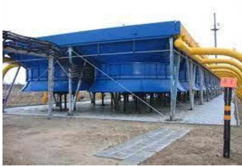
Рисунок 1.2 – Горизонтальний АПО газу типу 2ABГ-75
