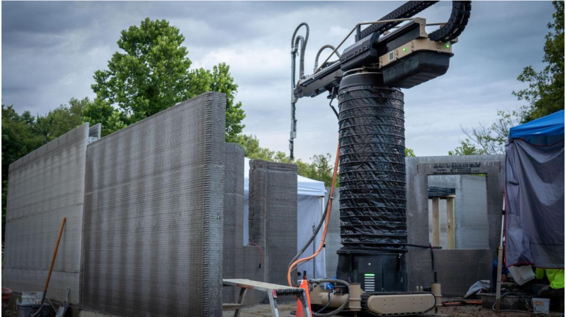
Рисунок 1.2 - Будівельний 3D принтер радіального типу компанії Apis Cor
