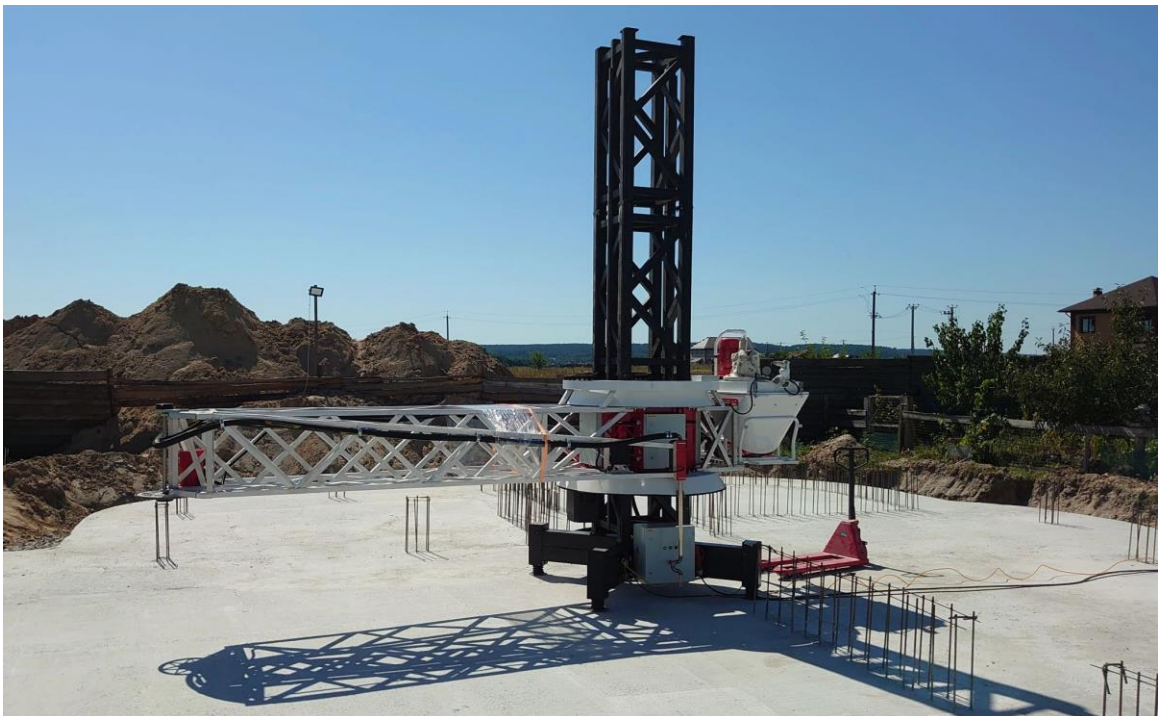
Рисунок 1.4 - Будівельний 3D принтер від компанії 3D Technology UTU
