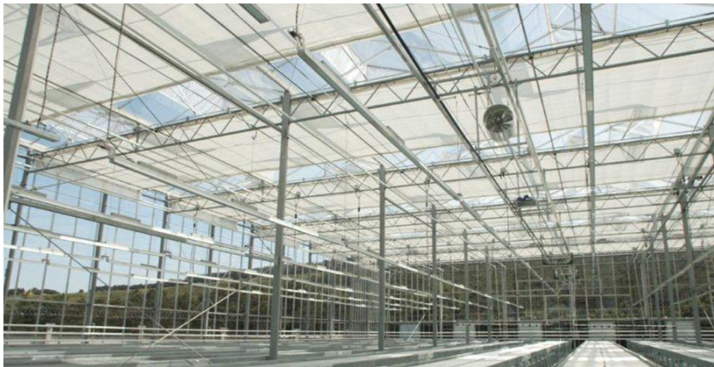
Рисунок 9 – Затінення в теплицях
