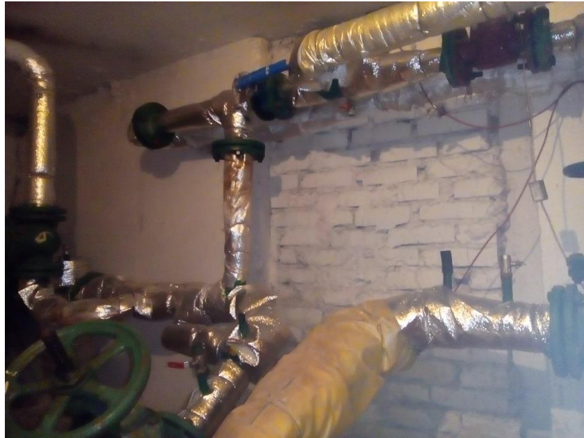
Рисунок 1.2 – Елеваторний вузол системи опалення
