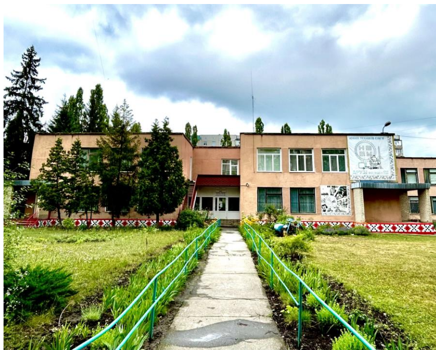
Рисунок 1.1 - Будівля Центру науково-технічної творчості молоді СМР
