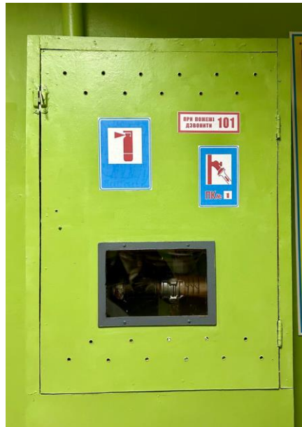
Рисунок 3.2 – Пожежний кран закладу
