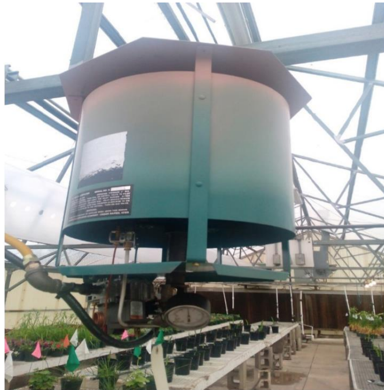
Рисунок 4.6 – Генератор \text{CO}_2 для комерційної теплиці, що може працювати як на пропані так і на природному газі [86, 87, 92]
