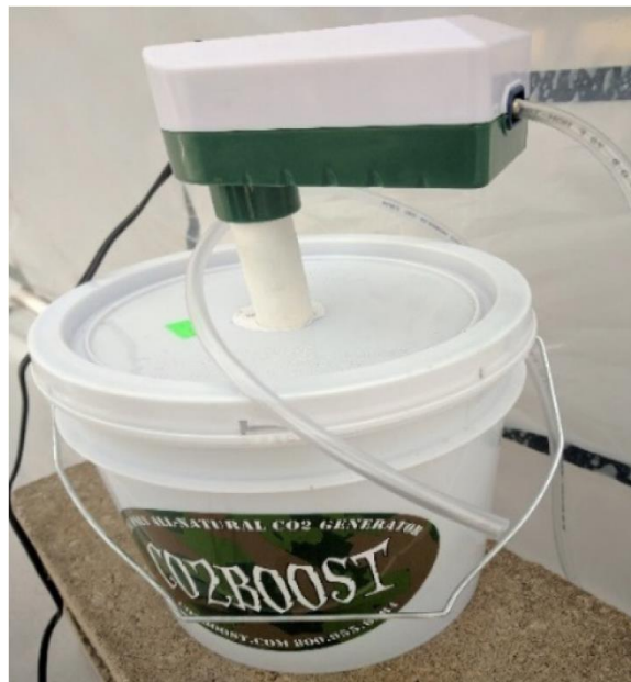
Рисунок 4.9 – Обладнання для утворення вуглецевого газу за допомогою процесу розкладання органічних відходів [86]
