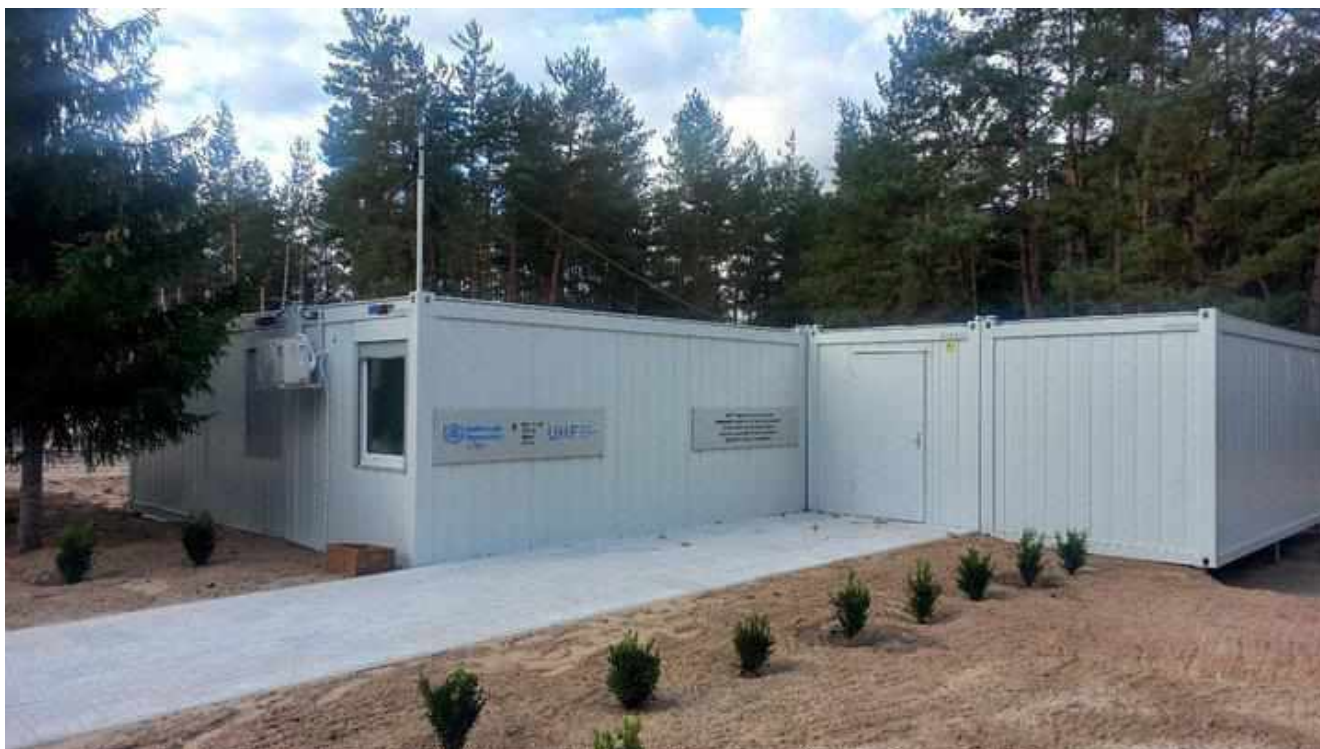
Рисунок 1.2 – Амбулаторія модульного типу в м. Охтирка [17]
